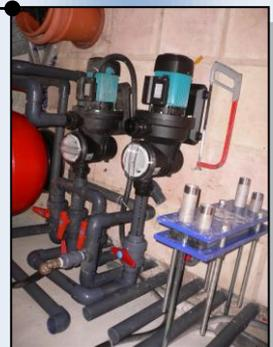
Un **Sistema de regulación y control** que se encarga de asegurar el correcto funcionamiento de la instalación para proporcionar un adecuado servicio de agua caliente y aprovechar la máxima energía solar posible.
